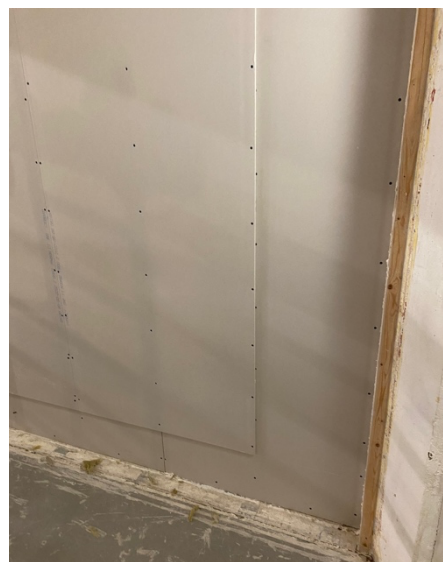
Figur 2: Gipslagren monterades så att skivorna hannade förskjutna mot varandra.
